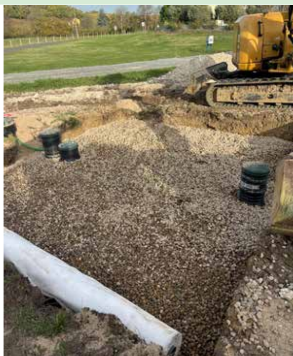
Installation d'un lit filtrant drainé à flux vertical sur la commune de Riocaud.
